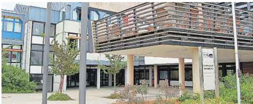
Für das Gymnasium Parsberg ist schon in naher Zukunft eine Generalsanierung zugesagt.
